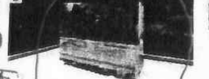
中之門石垣の特徴である、表面が広く奥行が浅い築石です。(縦向き)
