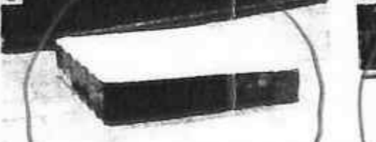
角石の破損部を切断した石で、母石は中之門石垣の中で最大級の花崗岩です。(縦向き) C
